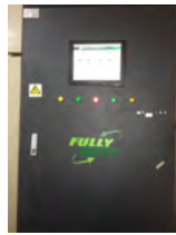
穩壓節能設備
